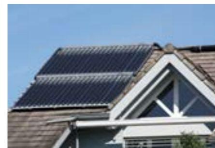
Röhrenkollektoren – Aufdach
