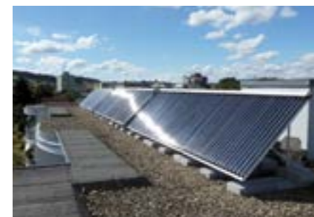
Röhrenkollektoren – auf Flachdach aufgeständert
