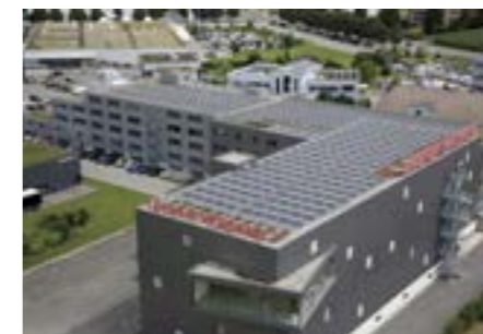
Photovoltaikanlage – Flachdach – Ost/West
