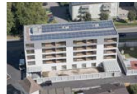
Photovoltaikanlage – Flachdach Ost/West
