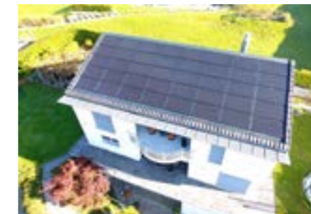
Photovoltaikanlage – Indach
