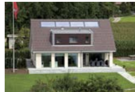
Flachkollektoren – Indachanlage Ziegeldach
