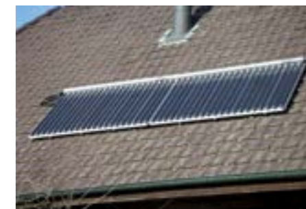
Röhrenkollektoren – Aufdach
